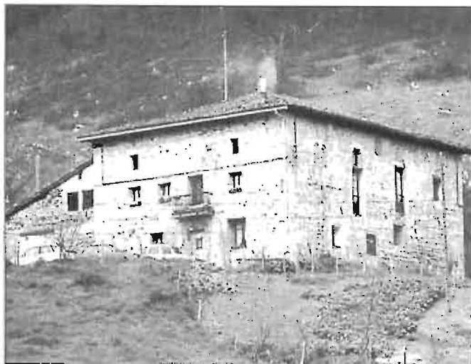
Casa torre Ospaz.
