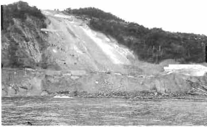
Abril, 2001 Desprendimiento de tierras entre Arrankasi y Arribaban (Foto P. Aldabaldetrecu)
