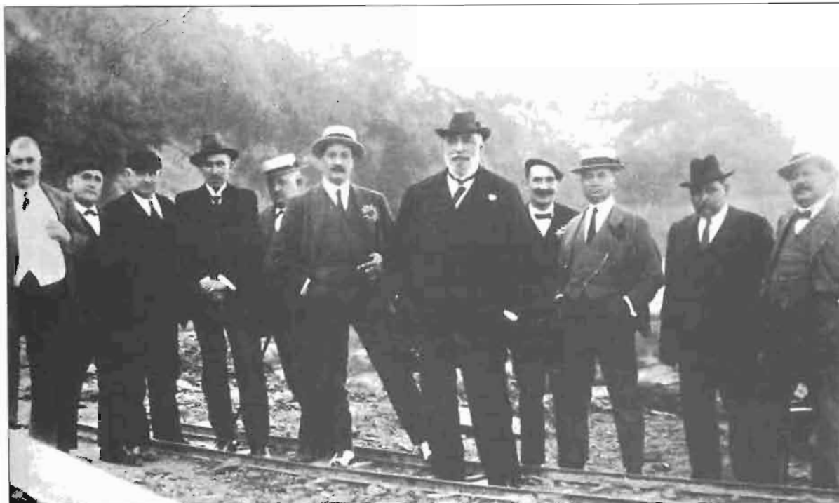
20 de Noviembre de 1913. Fermin Calbetón, visita las obras del dique de la margen izquierda de la ria (Foto "Deva Ayer")
