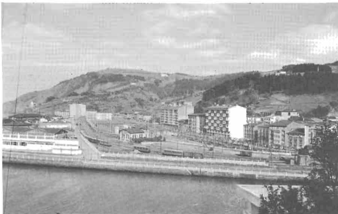
Vista de zona ferroviaria. Subestación y vagones de madera en vía muerta.
