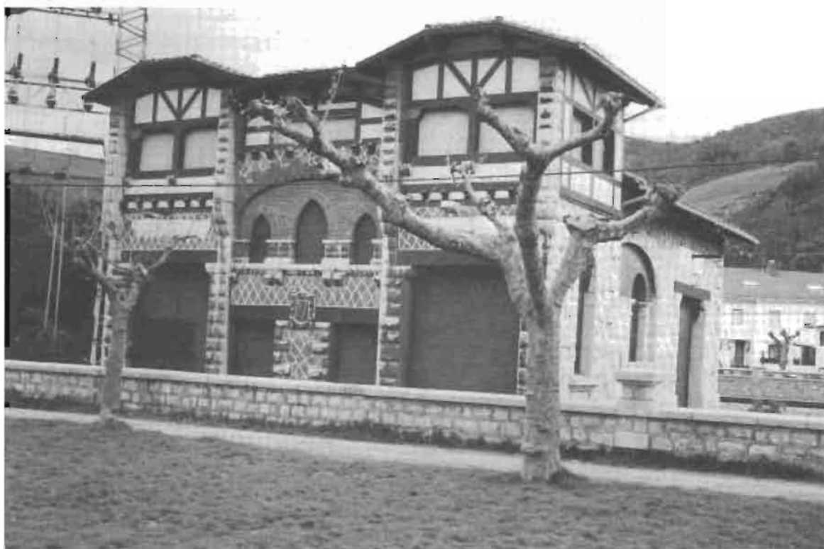
Subestación de transformación construida el año 1.929 (Foto: P.A.)
