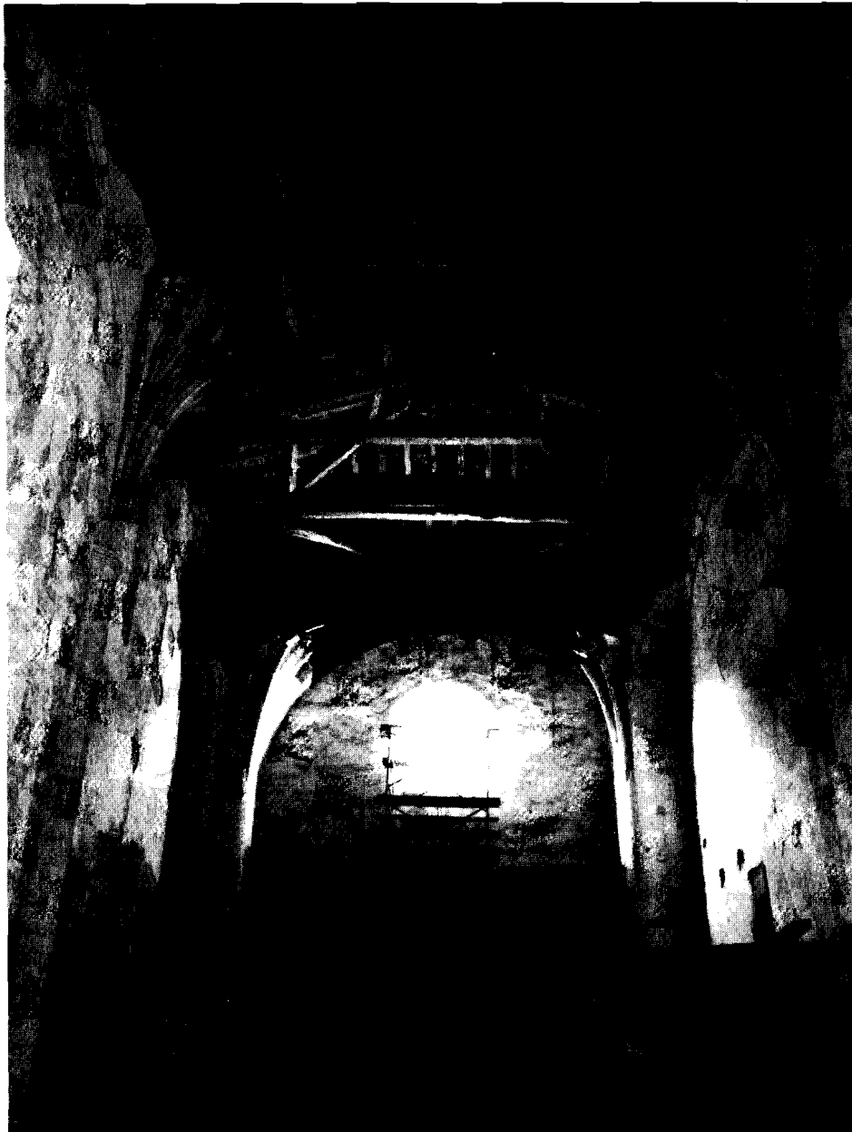
Vista de la situación actual de la cubierta y zona del coro en la Iglesia de SASIOLA
